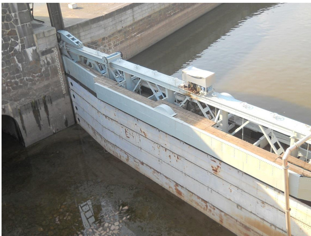
DPH osazené v dolním ohlavi VPK (2012) – hrazená výška 5 m
