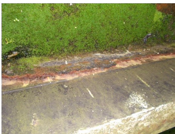
Koroze uvnitř hradidla, závěsné kladky MH
