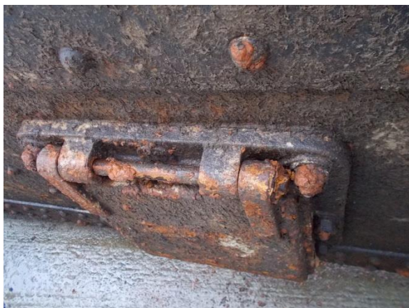
Poškození zavodňovacích ventilů – Zavodňovací klapky, vodítko
