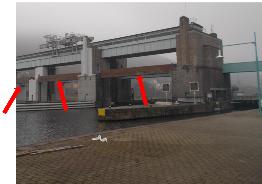
Pohled na umístění hradidel horního provizorního hrazení
