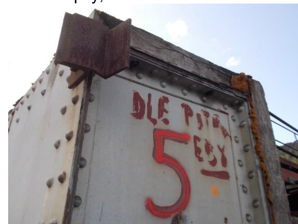
Poškození zavodňovacích ventilů – Zavodňovací klapky, vodítko
